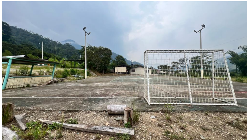
Foto 43. Cancha de uso múltiple, barrio urbano el Prado
