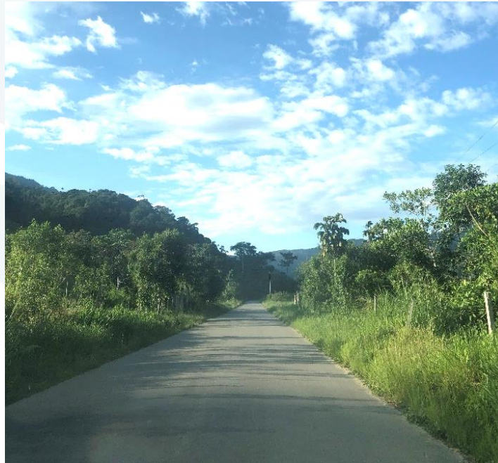
Foto 54. Vía asfaltada a barrios rurales
